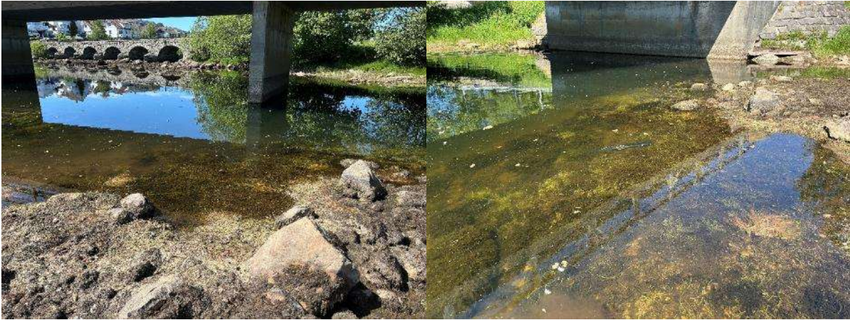
Figur 11. Ei bred og dyp renne som går på tvers av løpet under bilvegen ved Hestvad utgjør en fiskefelle ved lav vannføring. Ved forholdene på bildet var nærmeste vannspeil av betydning nedstrøms Eidehølen og søndre løp ved Risholmen.
